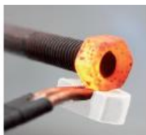
rozsdás csavarok kimelegítése
